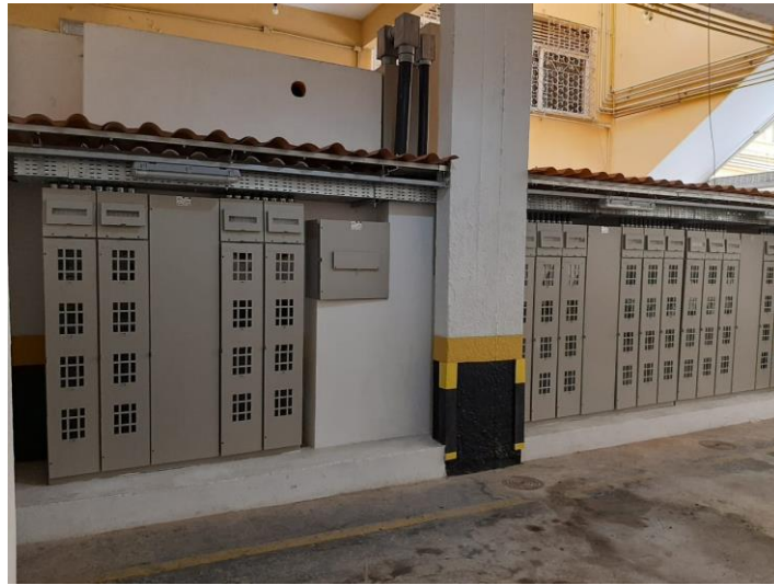
Figura 6 - Aplicação dos painéis metálicos PDMD e PPGP padrão da Light
