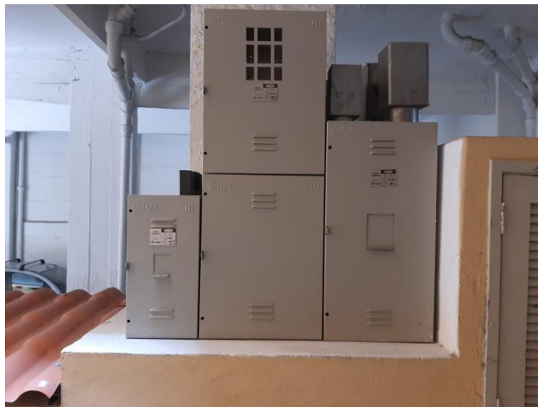
Figura 7 - Aplicação das caixas metálicas CPG 600, CPG 200 e painel CSM 200 Light
